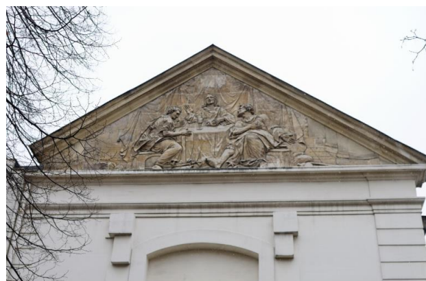
Le fronton du derrière de l'église prise côté Cimetière.
